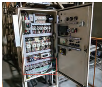
図4: 電流値測定のために取りつけたクランプ計
